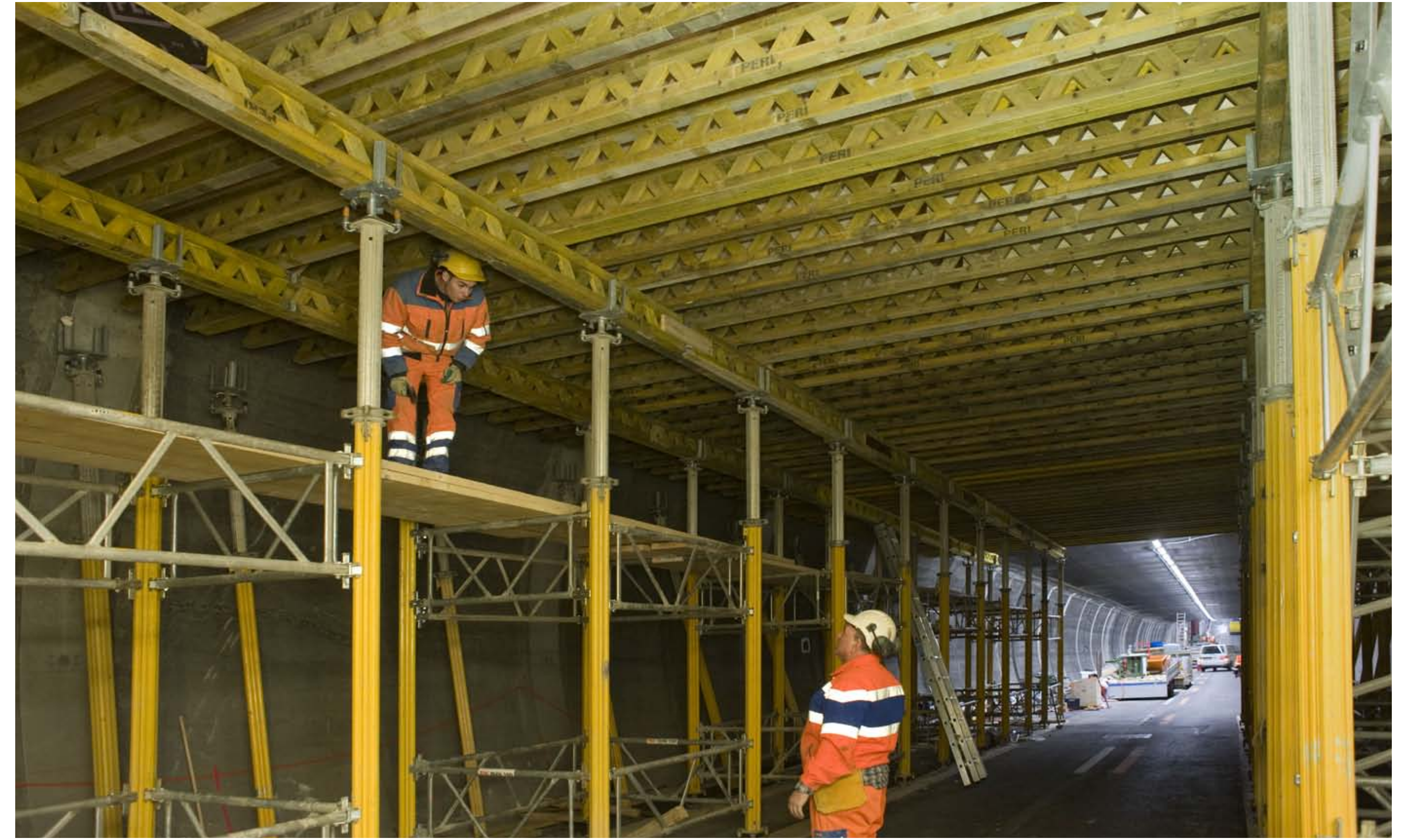
Schalen neue Zwischendecke von unten
