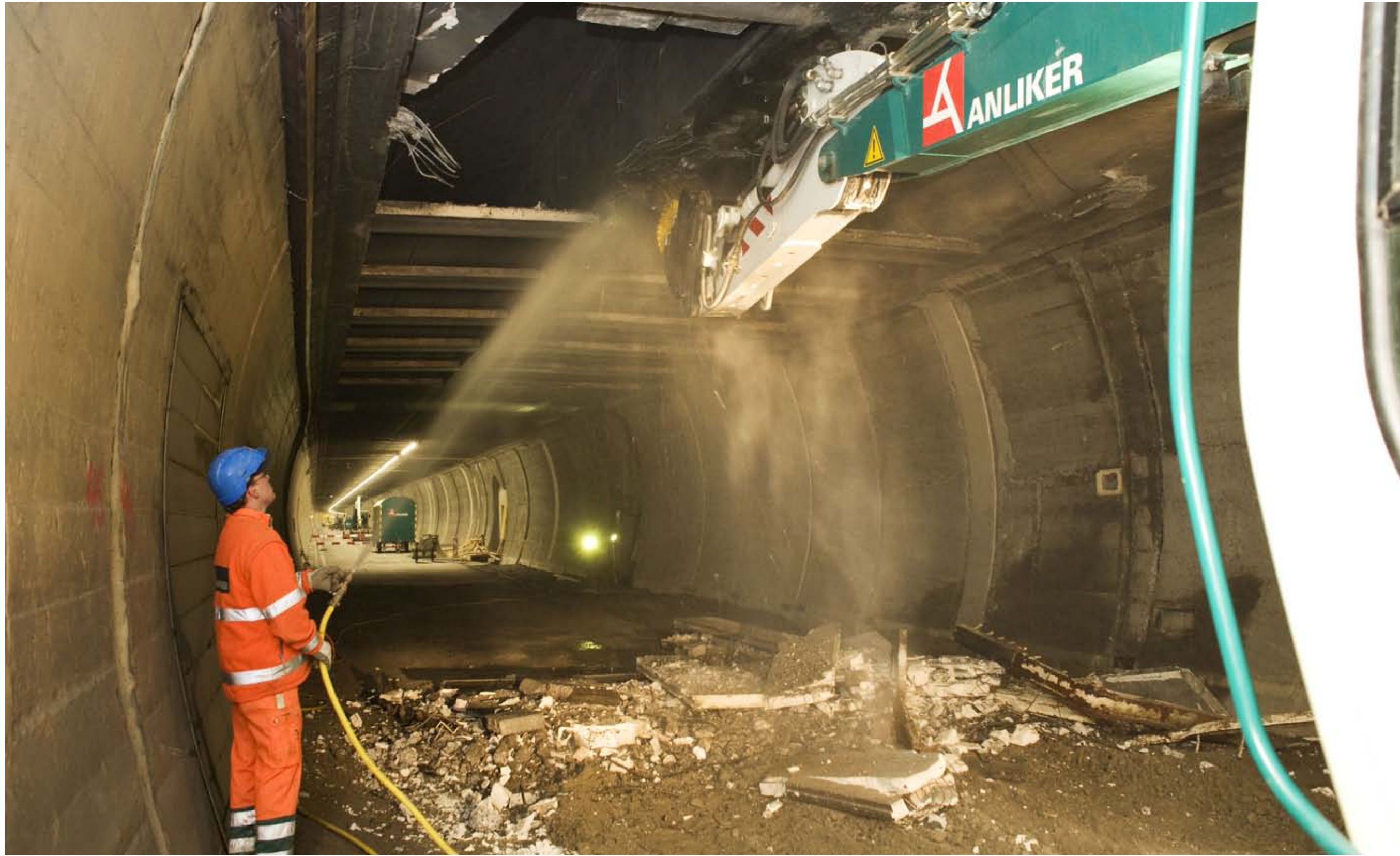
Abbruch alte Zwischendecke
