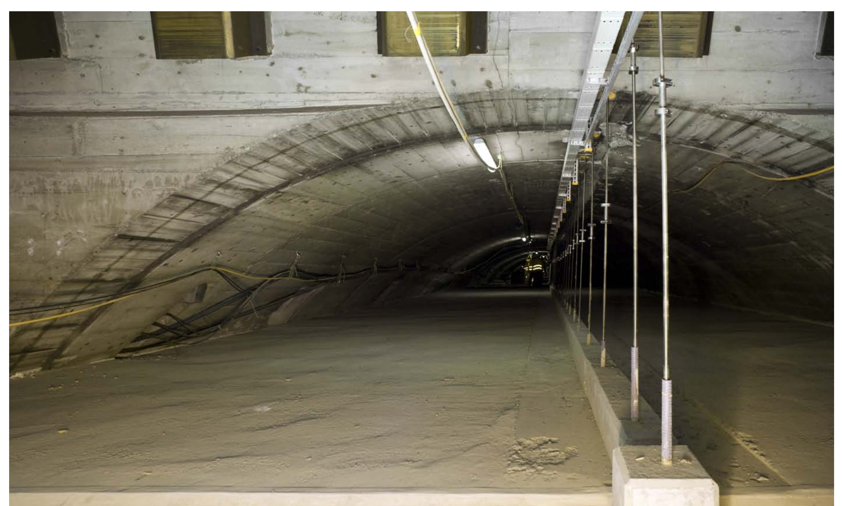
Fertige Zwischendecke von oben
