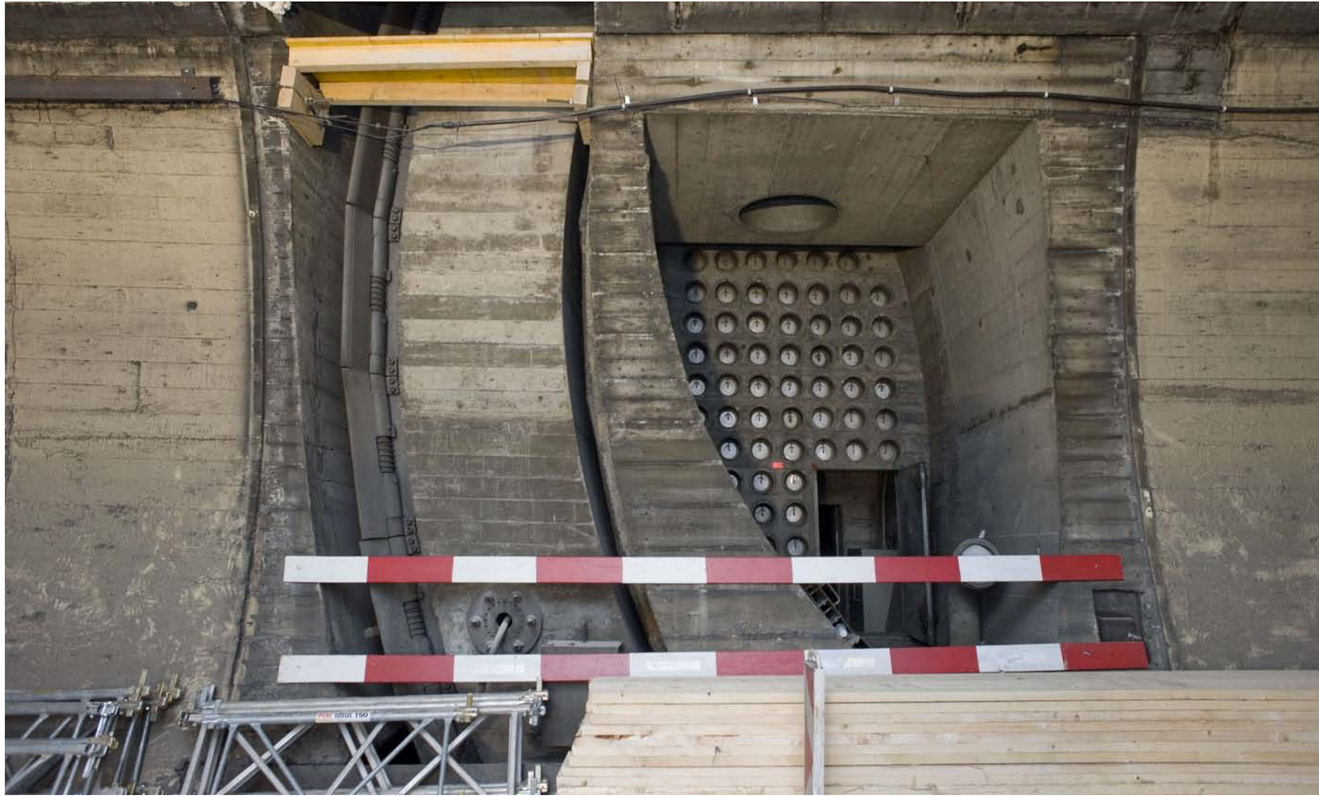
Panzertor Nord vor Rückbau
