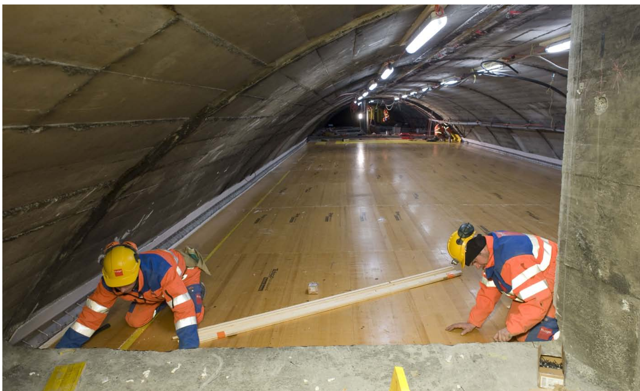
Schalen neue Zwischendecke von oben
